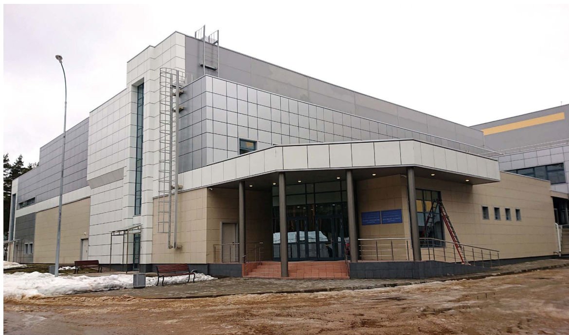
Рис. 5. Здание экспериментального комплекса «Фабрика сверхтяжелых элементов».
