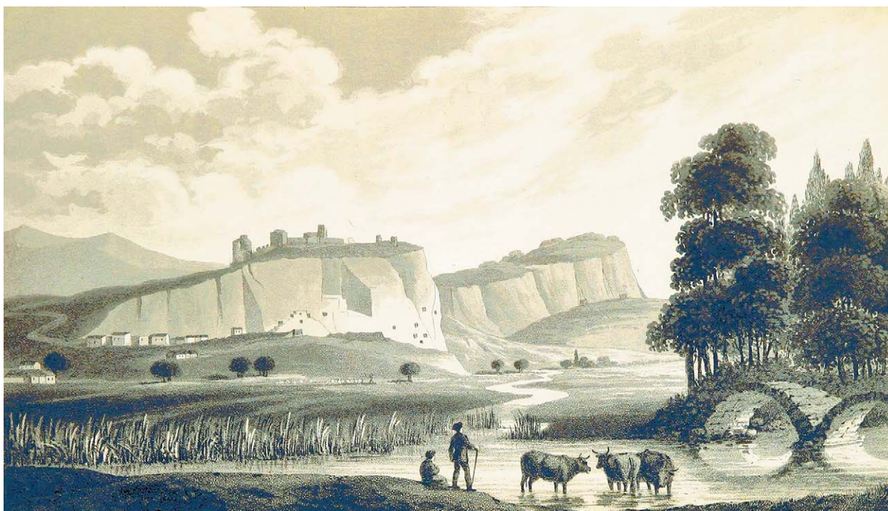
Рис. 7. Инкерман. Гравюра по рисунку Дж. Уэбстера (1827). На заднем плане — Монастырская скала с пещерными сооружениями византийской эпохи и средневековой крепостью на вершине
