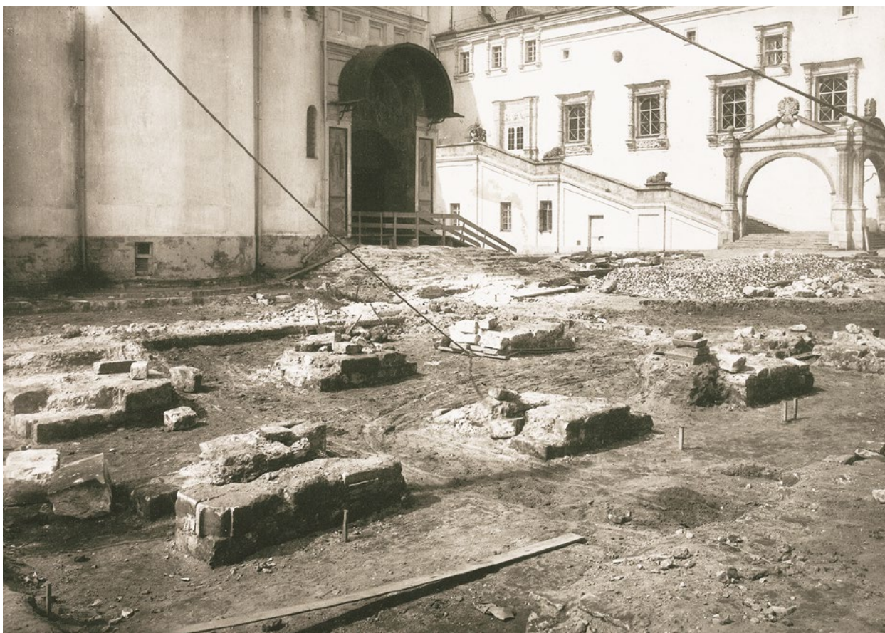
Ил. 4. Соборная площадь во время реставрационных работ 1913–1914 гг. Вид от Архангельского собора на Благовещенский собор, Красное крыльцо и Грановитую палату («Остатки старого здания между Благовещенским и Архангельским соборами»). Москва. 1913. Фотография-фототипия П.П. Павлова. Музеи Московского Кремля
