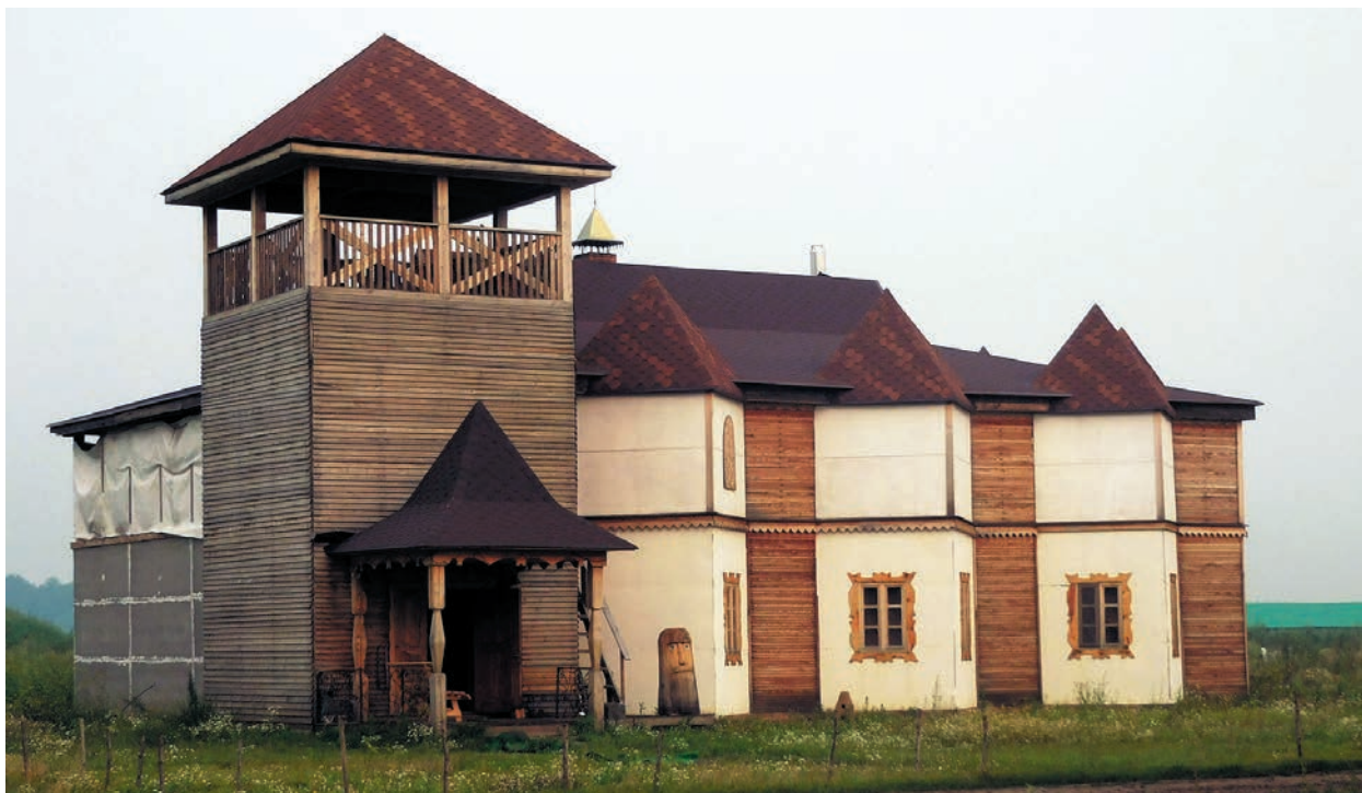
Фото 6. Общественное сооружение («трапезная»). Поселение Азь Град, Омский район Омской области
