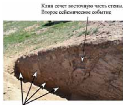
Рис. 8. Фото южной стенки траншеи, пройденной в восточной стене Тоссорской средневековой крепости. Вид на юг. Видны деформации, относящиеся к двум сейсмическим событиям
