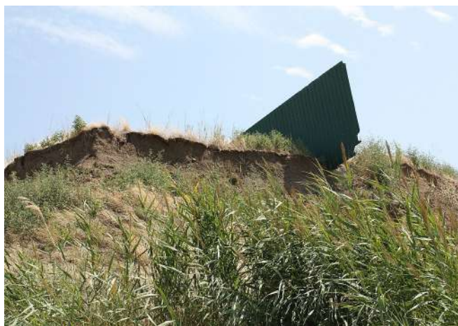
Обрушение берега в селе Беглиця
